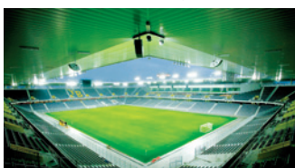
MONTAWALL® Stade de Suisse, Bern (CH)
