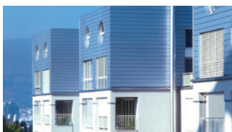
MONTAFORM® Wohnsiedlung, Olten (CH)
